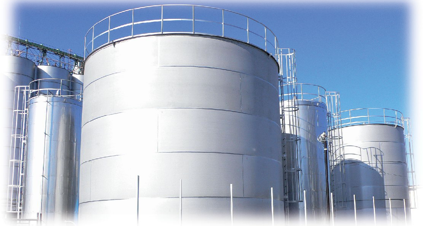
溶接が創り出す造形美・ステンレス製大型タンク
